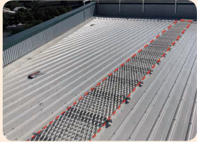
취약 지붕재 이동-작업구간은 작업발판과 안전덮개 또는 추락방지망 설치
