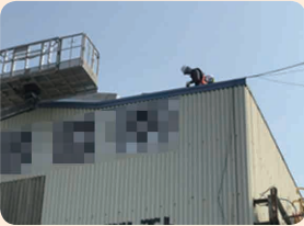
지붕 단부 떨어짐 방지조치 미실시로 떨어짐 위험
