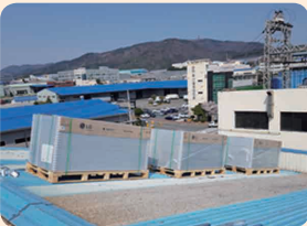
지붕 위 자재 집중적재로 인한 지붕재 파손 위험
